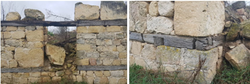
Şekil 8-9: Derviş Bey Camii'nin duvar örgüsü ve hatıl detayları (2019).
